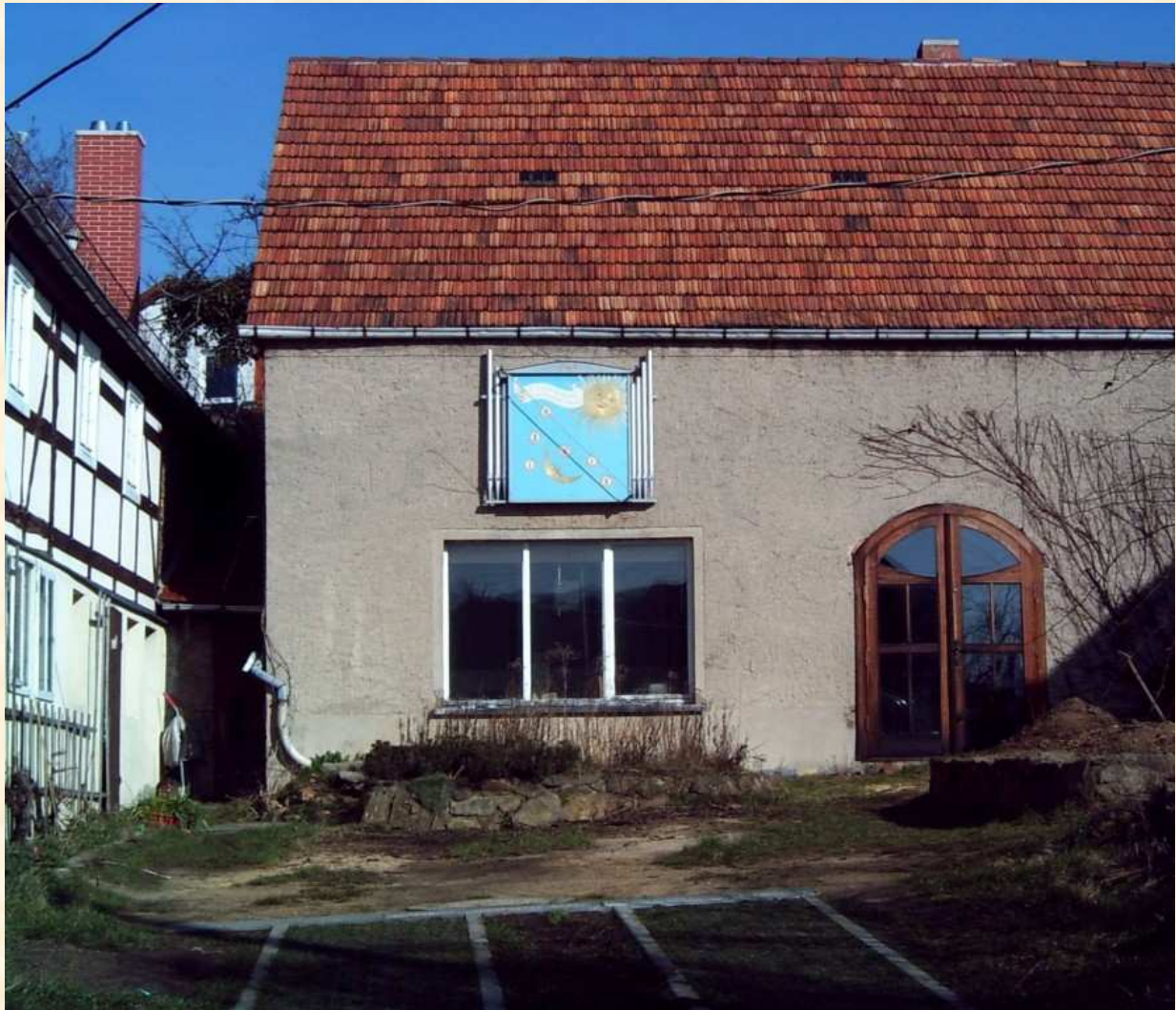
Ansicht des Werkstattgebäudes mit Sonnenuhr, Aufnahme von Christoph Rühle, 2007
